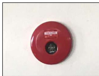
ภาพที่ 1-12 อุปกรณ์แจ้งเหตุเพลิงไหม้ (Manual Station)
