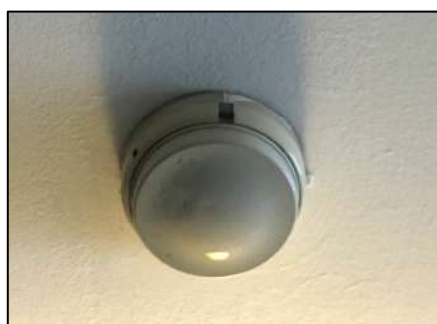
ภาพที่ 1-10 อุปกรณ์ตรวจจับควันและความร้อน (Smoke and Heat Detector)
